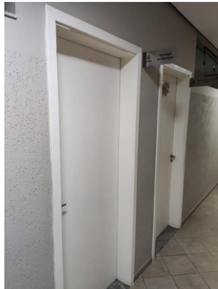
Figura 14: Data Center da CMA
